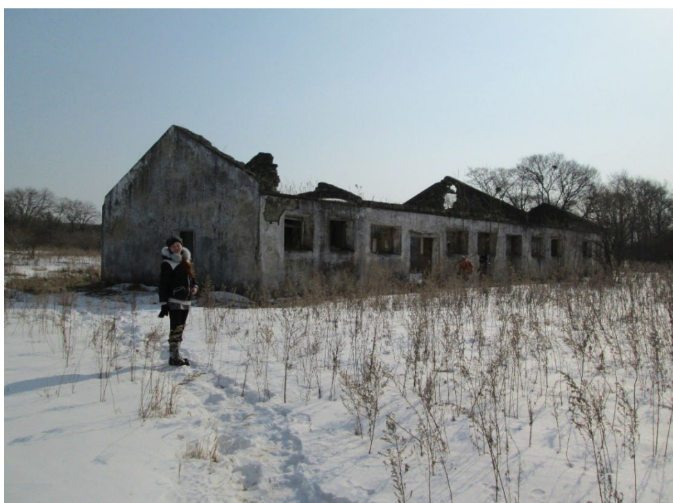
Рисунок 20 – Старое здание на аэродроме «Петровка»
