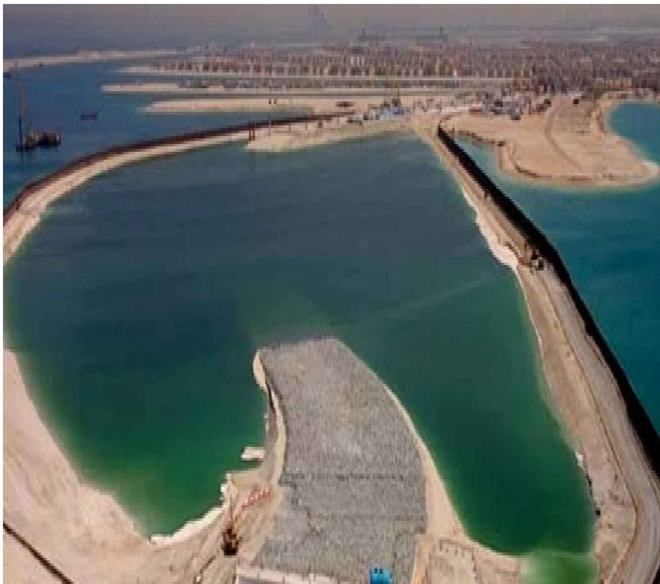
Рисунок 4. Строительство двух дамб для связи с искусственным островом в Дубае.
